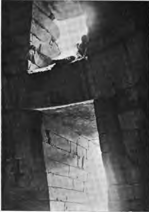
Fig. 129. — Tombe couverte en coupole à Mycènes (Trésor d'Atrée). Construction par encorbellement d'anneaux concentriques à lits horizontaux.
